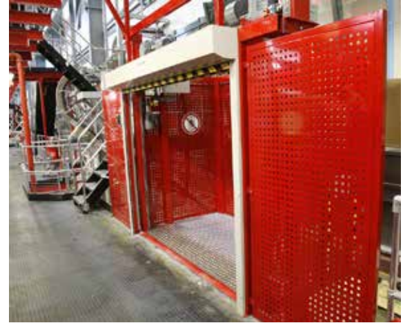
Lift integriert in Stahlbühne
